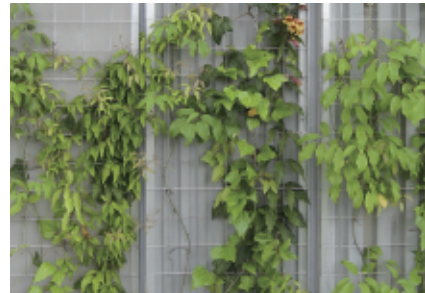
メースリブグリーン工法（仮称） 試験施工写真
